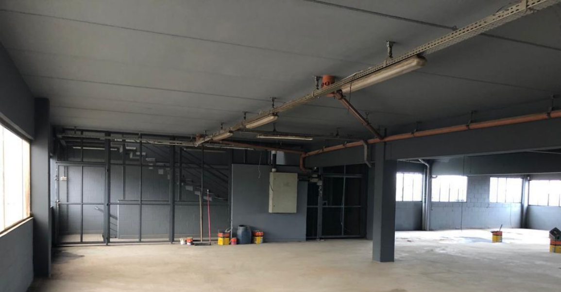
Vista Interna - 1º Pavimento
