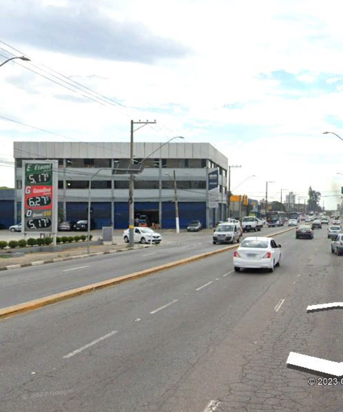
VISTA SENTIDO SUZANO
