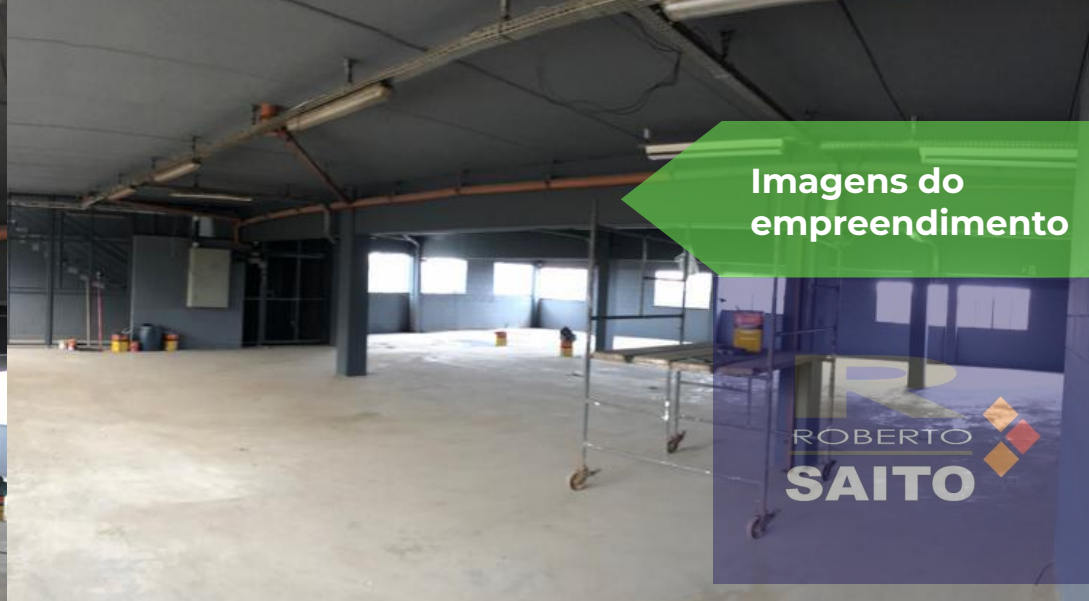
Vista Interna - 1º Pavimento
