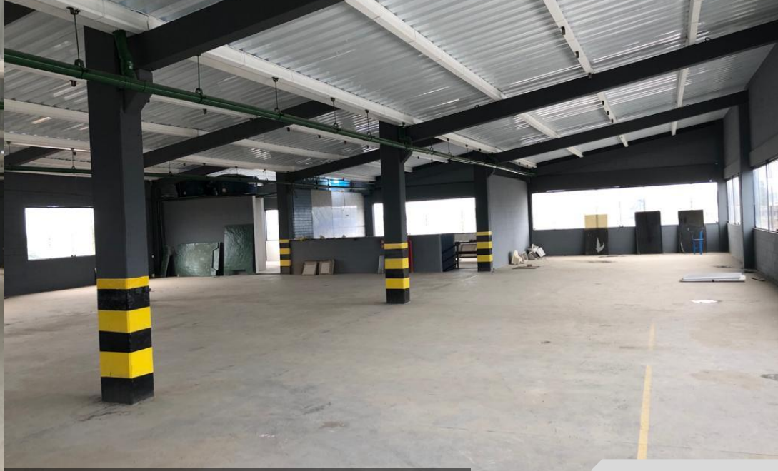
Vista Interna - 2º Pavimento
